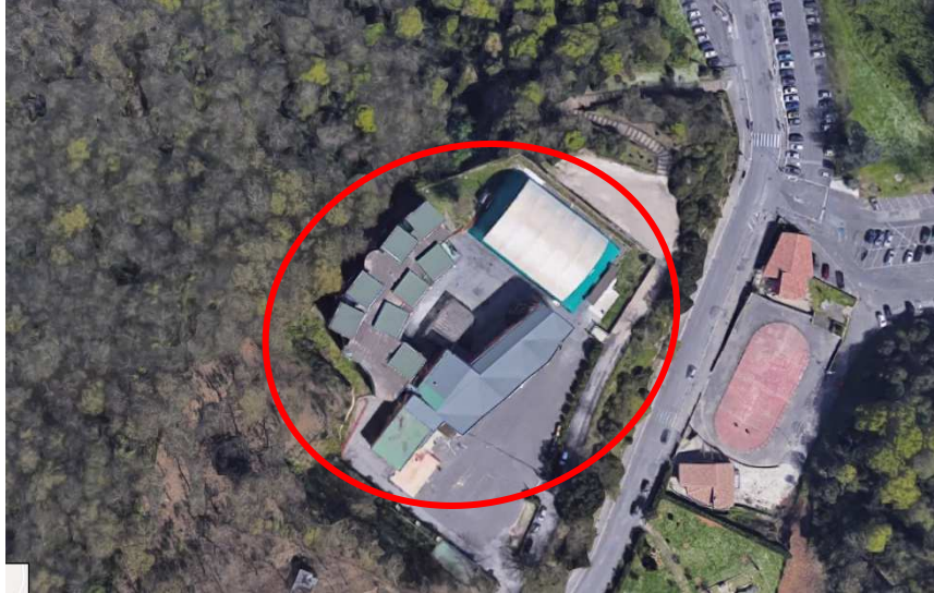
Figura 1 Vista dall'alto dell'edificio
